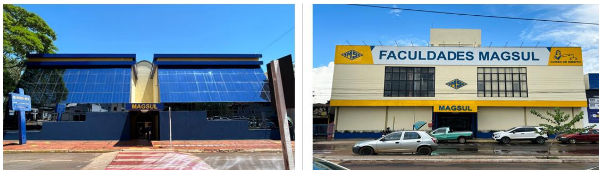
Imagem 15. Fachadas Sede e Anexo II recém reformadas.
